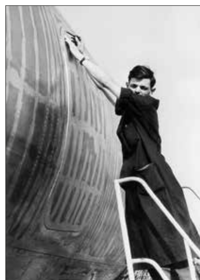
Der Druckprüfung am 15. Juni 1959 ging eine eingehende Inspektion voraus. Anscheinend hat die hintere Frachttür Probleme beim hydraulischen Verschließen, da die Tür noch über die Außenkontur steht. Unten sieht man aufmerksame Beobachter hinterm Sicherheitszaun.
