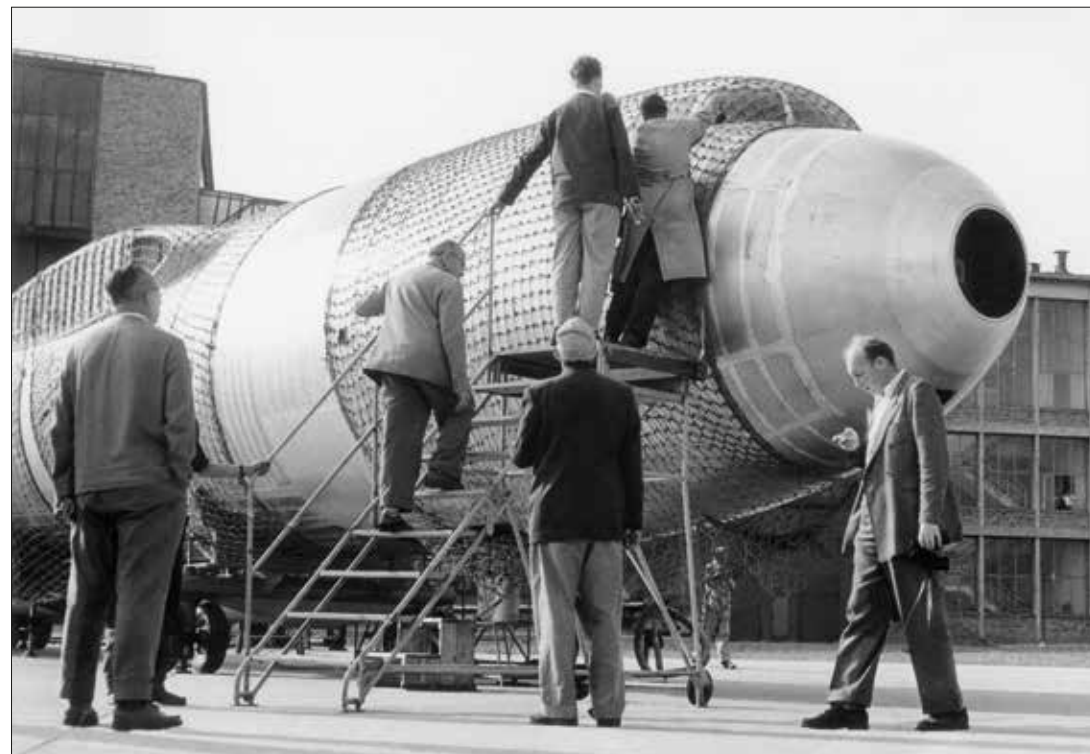
Der Druckprüfung am 15. Juni 1959 ging eine eingehende Inspektion voraus. Anscheinend hat die hintere Frachttür Probleme beim hydraulischen Verschließen, da die Tür noch über die Außenkontur steht. Unten sieht man aufmerksame Beobachter hinterm Sicherheitszaun.
