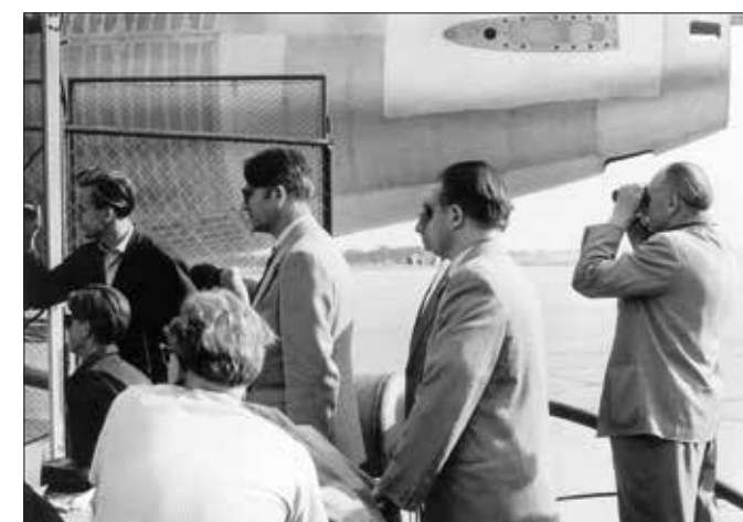
Der Druckprüfung am 15. Juni 1959 ging eine eingehende Inspektion voraus. Anscheinend hat die hintere Frachttür Probleme beim hydraulischen Verschließen, da die Tür noch über die Außenkontur steht. Unten sieht man aufmerksame Beobachter hinterm Sicherheitszaun.
