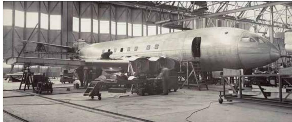
Der 2. Prototyp bildete die erste Maschine, die vollständig unter Serienbaubedingungen gebaut wurde (Bilder oben und unten). Rechts im Bild die Explosivdarstellung der 13 Rumpfsegmente mitsamt dem unteren Flügelmittelstück.
