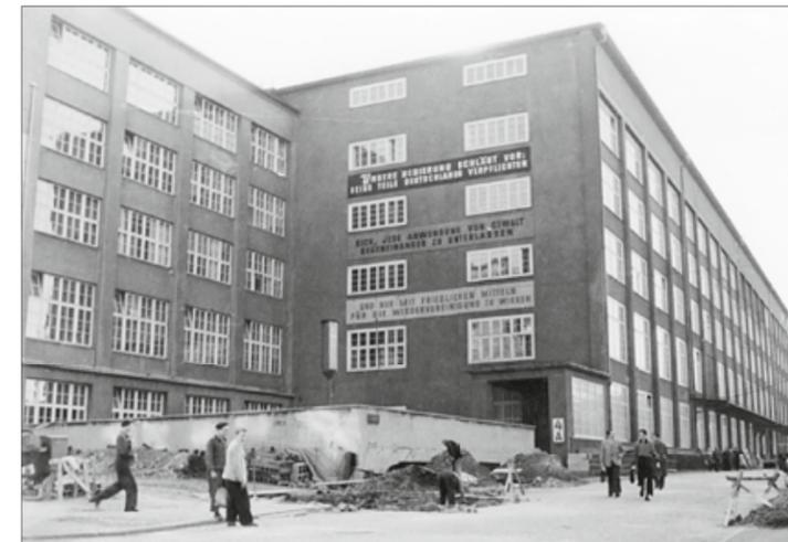
Links der Gebäudeteil, wo die Motorenproduktion stattfand. Ganz unten befand sich die Mechanische Fertigung, darüber die Verzahnung und die Berufsschule. Im hinteren Teil (nicht sichtbar) war anfangs die Endmontage der Motoren. Der Luftschraubenbau befand sich ganz hinten im Erdgeschoß.
