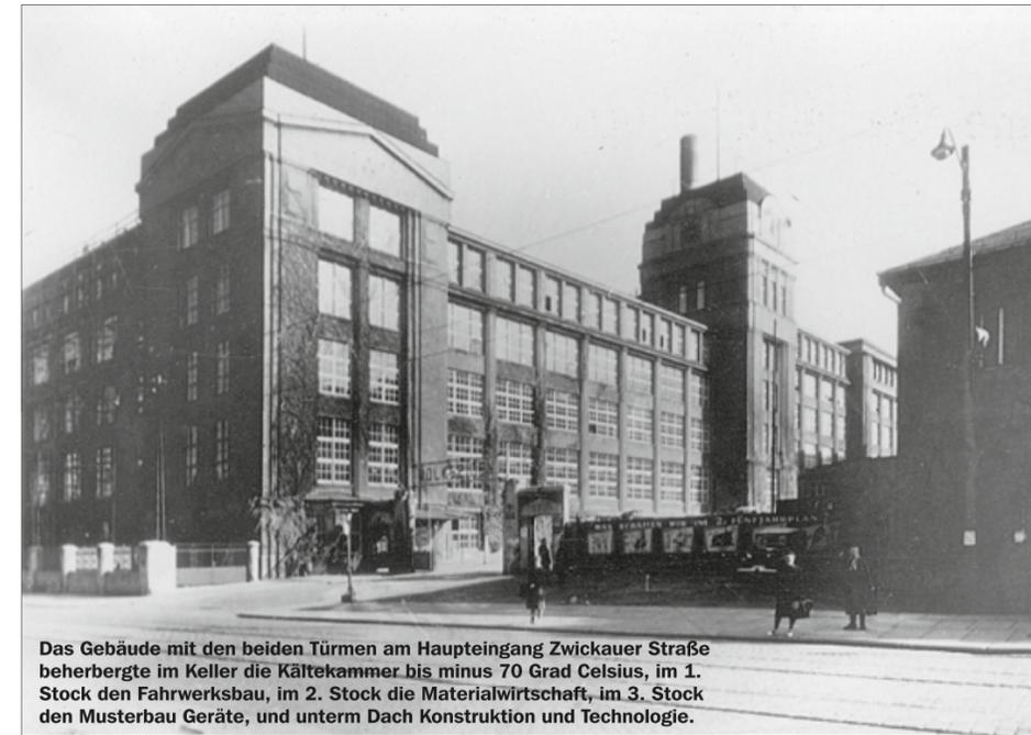
Das Gebäude mit den beiden Türmen am Haupteingang Zwickauer Straße beherbergte im Keller die Kältekammer bis minus 70 Grad Celsius, im 1. Stock den Fahrwerksbau, im 2. Stock die Materialwirtschaft, im 3. Stock den Musterbau Geräte, und unterm Dach Konstruktion und Technologie.
