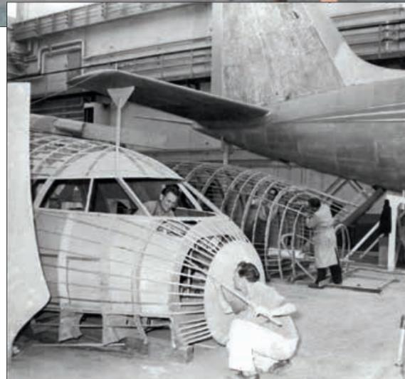
ler Besetzung ein ganzer Flug simuliert werden, um zu erfahren, wie das Beladen der Frachträume, das Beschicken der Küche, das Entsorgen von Abfällen und Toiletteninhalten funktionierte.
